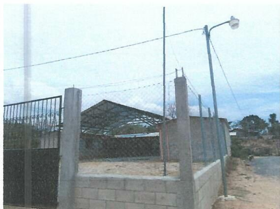
Foto 3: repello y pintura de muro perimetral
