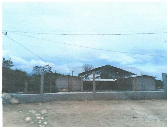
Foto 2: repello y pintura del establecimiento
